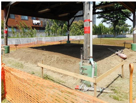
2017年5月20日 養生工
